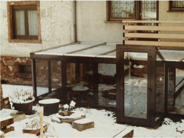
Wintergarten im Untergeschoss, der genau an die spezifischen Ortsverhältnisse angepasst wurde, was der überdachte Treppenaufgang mit Ausgangstür eindrucksvoll zeigt.
