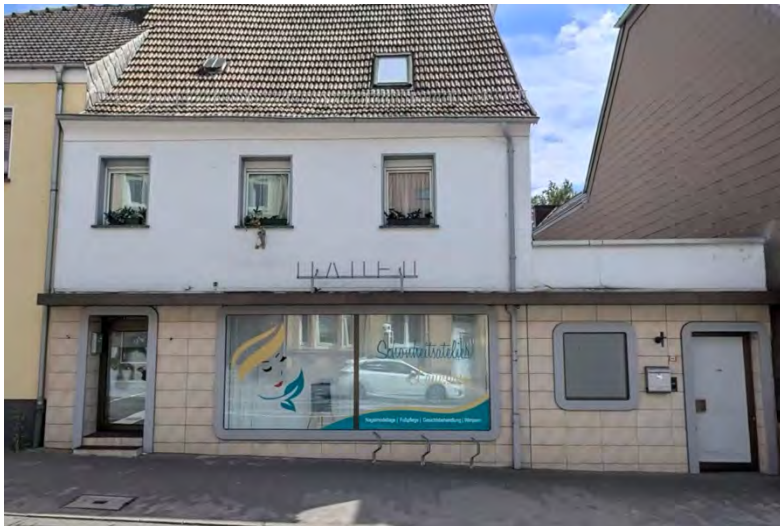
Der ehemaligen Metzgerei Mader fertigten wir zu dem neuen Schaufenster und den Eingangstüren spezielle Umrandungen mit abgerundeten Ecken, die der Idee des Rohrbacher Architekten Thiel entsprachen.
