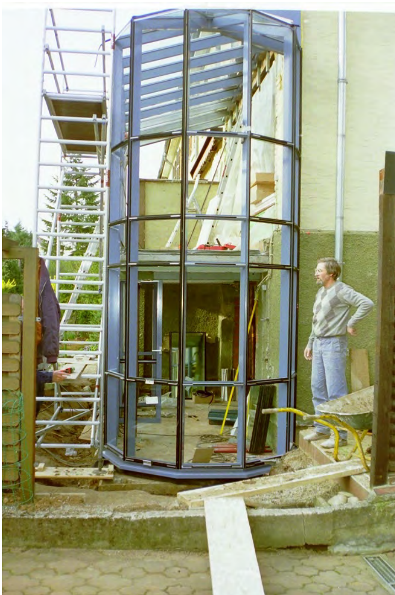
Wintergarten aus Pfosten-Riegelkonstruktion in Heidelberg. Später wurde noch eine gewendelte Treppe eingebaut, mit der ein Ausgang vom Obergeschoss in den Garten ermöglicht wurde.
