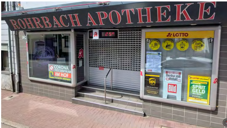
Schaufenster mit gerundeten Rahmenprofilen, damals ein Highlight... Geplant von Heinz Wadle und umgesetzt von Metallbau Schmidt.
