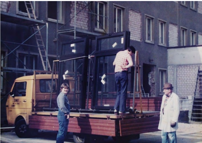
Erneuerung der Fenster an einem Gebäude der Uni-Klinik in Homburg.
