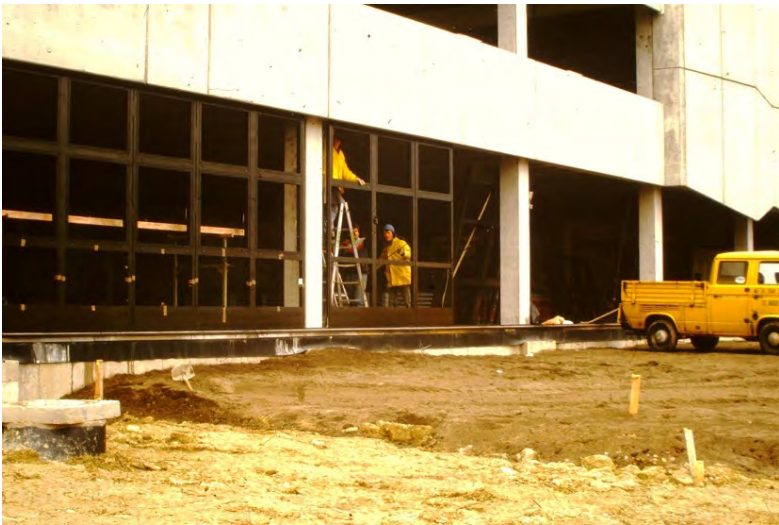
Neubau der Firma Leysser, Bauelemente und Werkzeuge in Trierweiler
